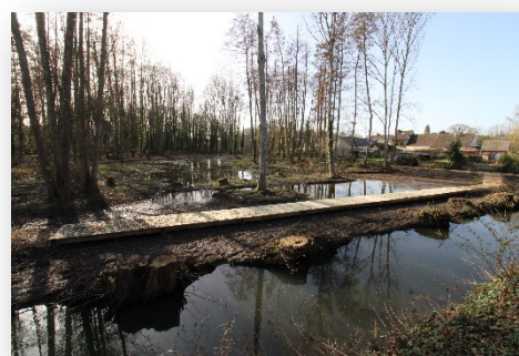
Figure 7 Vue du platelage
