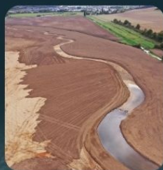
6. Remise en eau
