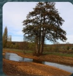
9. Travaux sur le canal
