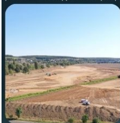
4. Terrassement du fond de vallée
