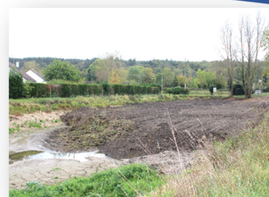
Figure 9 Ballastière en cours de comblement (2024)
