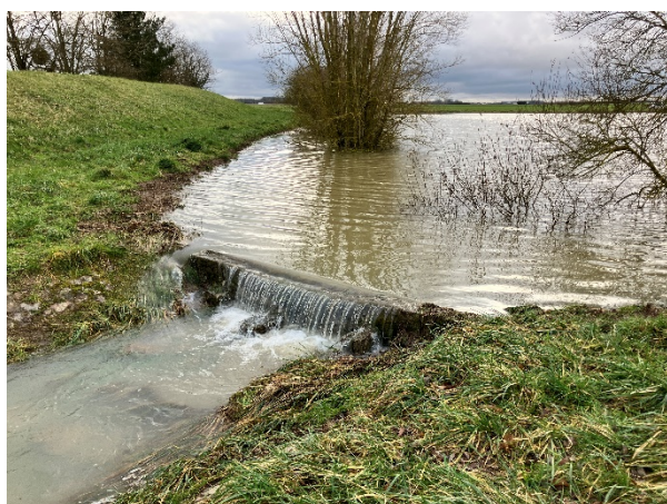
Figure 17 Bassin pluvial de la mare neuve saturé en janvier 2025
