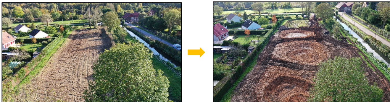
Figure 10 Travaux de terrassement et création des mares
