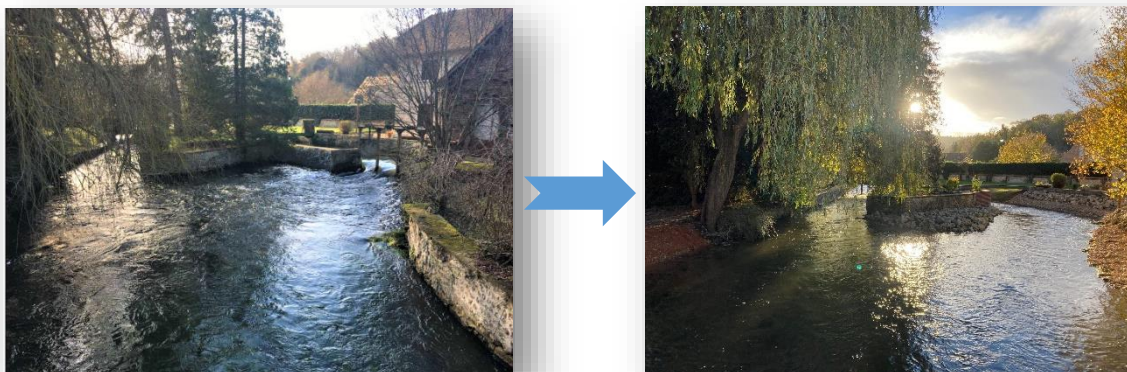
Figure 7 Avant et après travaux – vue aval
