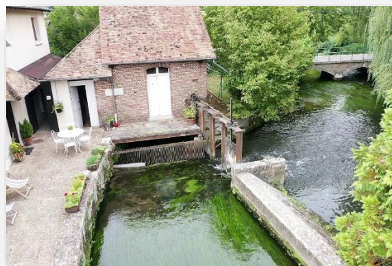
Figure 6 Vue amont de l'ouvrage
