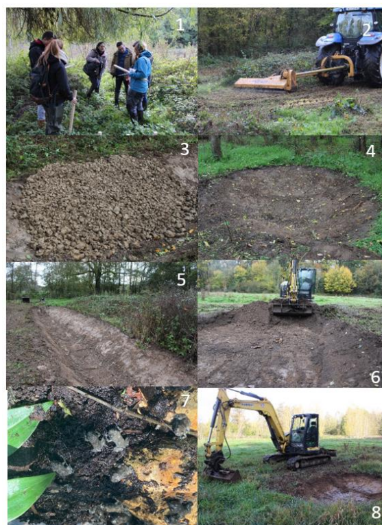
Figure 10 1) Réunion de piquetage 2) Broyages préalables 3) mise en place de pierriers 4) création de mare 5)&8) Création fossés 6) étrepage 7) lâcher de crapelets
