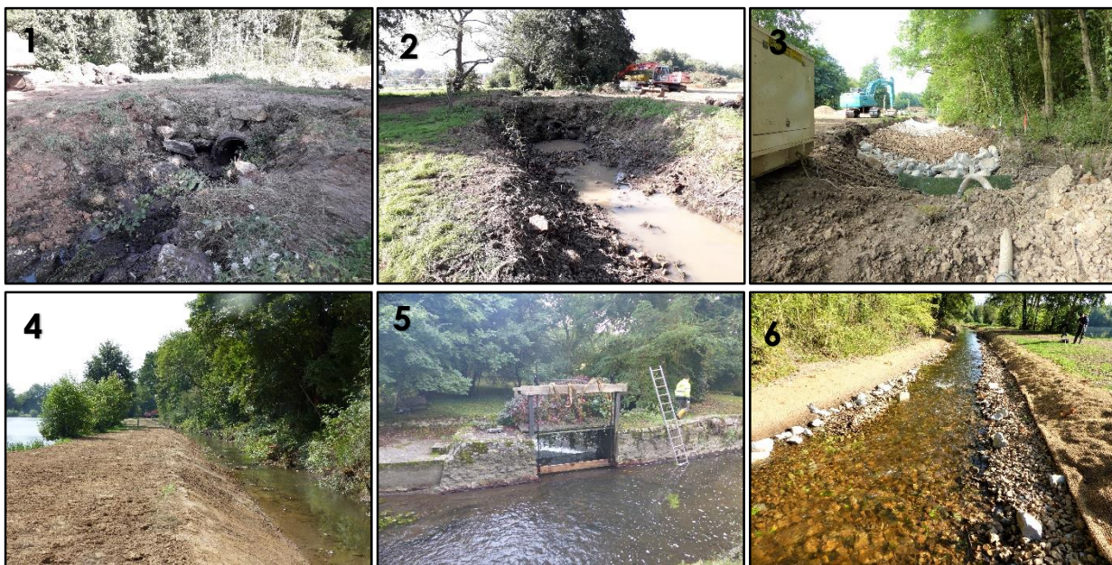
Figure 5 1)Buse amont 2)Buse aval 3)Seuil 4)Reprofilage berge Norte 5)Ouvrage La Porte 6) Mise en eau du seuil
