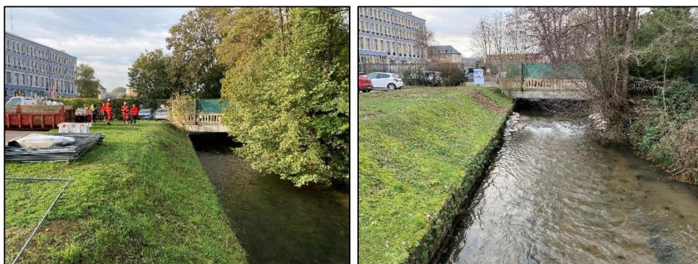
Figure 12 Seuil définitif aval avant/après travaux
