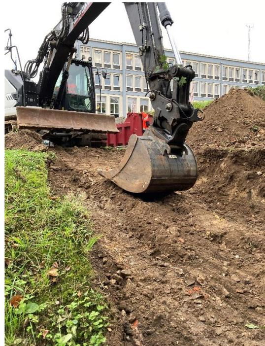
Les travaux ont démarré de la rive gauche avec la création de la bêche et le profilage de la berge. L'entreprise a mis en œuvre des enrochements 300-600 mm et matrice 40-120 mm après avoir installé un géotextile plaqué à la berge. Afin de ne pas impacter les racines des arbres présents en rive gauche, et risquer une déstabilisation de berge, le reprofilage a été limité. Le pied de berge est alors conforté par les enrochements, en limitant l'intervention sur la partie supérieure.
