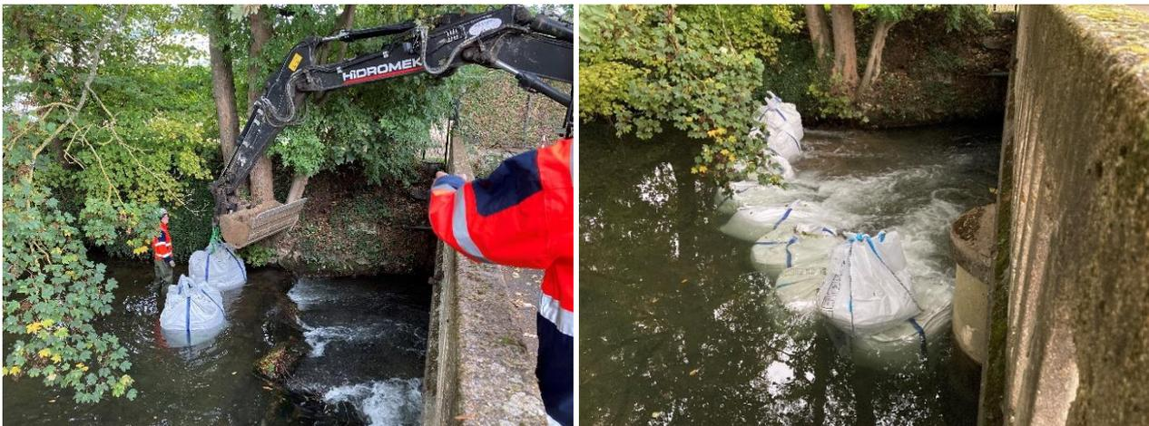
Un barrage en géotextile tissé est ensuite mis en place en amont du seuil, au droit du pont. Le barrage aval est d'abord tendu devant le barrage amont. Les poissons ont été poussés hors de la zone chantier et le barrage aval fixé.
