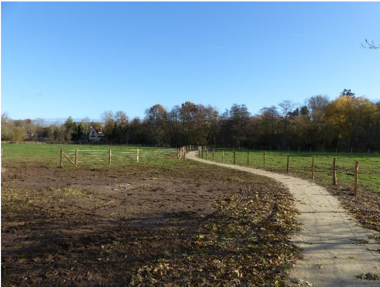
Seconde tranche de travaux
