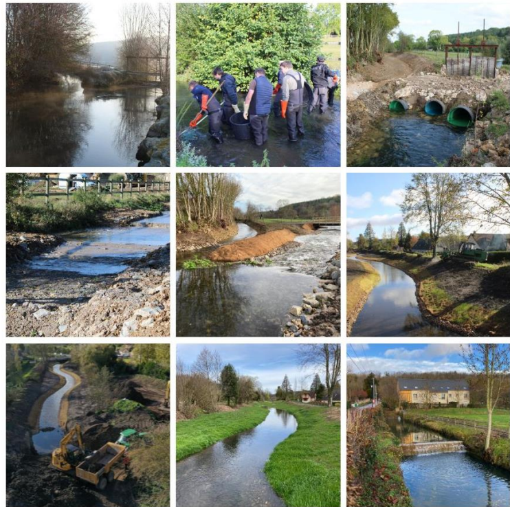
Figure 7 Visuels des travaux
