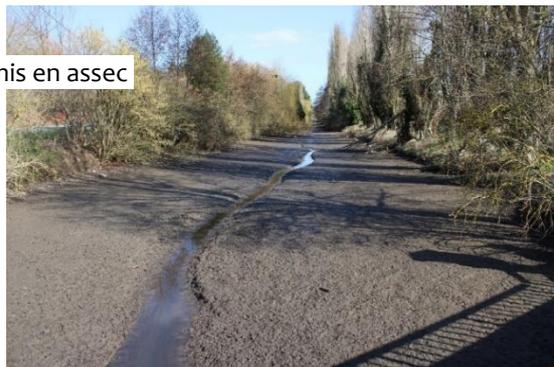
Quelques dizaines de mètres après le vannage, le canal du Rouloir s'élargit rapidement à 7 m, puis 12 m, 15 m, et même parfois 18 m. On constate un faciès très lentique et un bras très ensasé.
