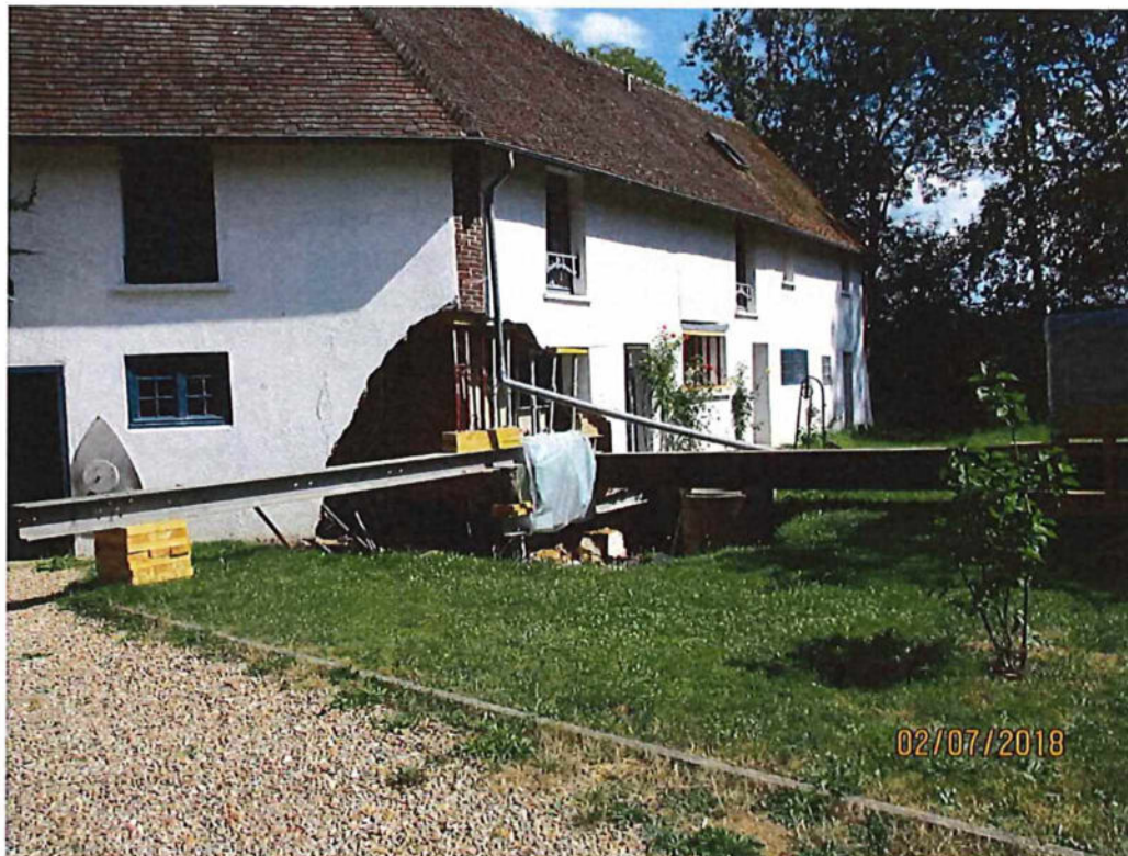
Figure 11 : Karsts reconnus à proximité des 2 forages envisagés : (a) karst étagé de Brosville, cartographié par les spéléologues de Dieppe ; (b) Effondrement karstique sous le « moulin de Février » en 2018 (à proximité du site du forage n°2 envisagé)
